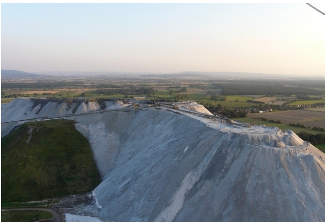
Abbildung 1 - Luftbild der Kalihalde Sigmundshall wenige Tage vor der Schlamm-Lawine. Man erkennt, dass auf dem Halden-Top kaum Platz für größere Pfützen vorhanden ist.“ 8
